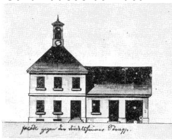
Betsaal (Schulhausentwurf 1818) Quelle Ortschronik
