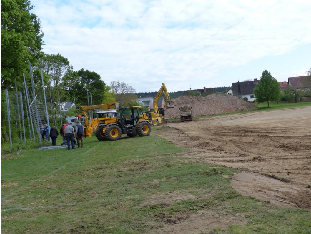
3. Mai 2019 Abbau des Ballfangzauns in Eigenarbeit
