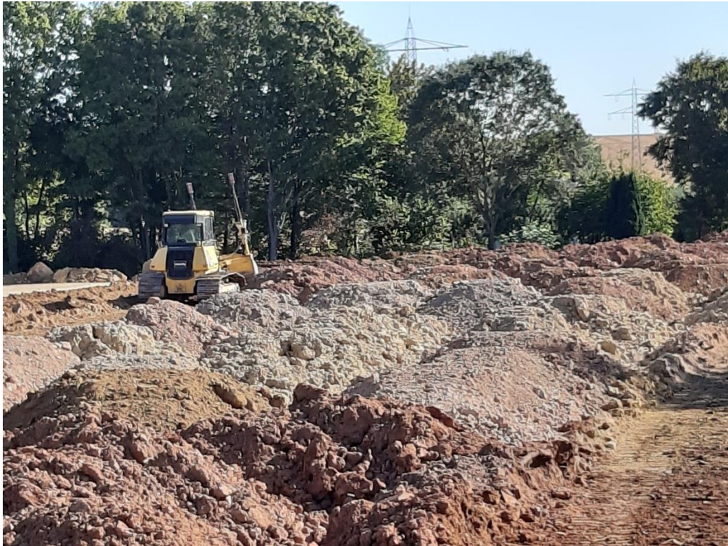
19. September 2019 Lasertechnologie an Planierdrape sorgt für ebene Verhältnisse
