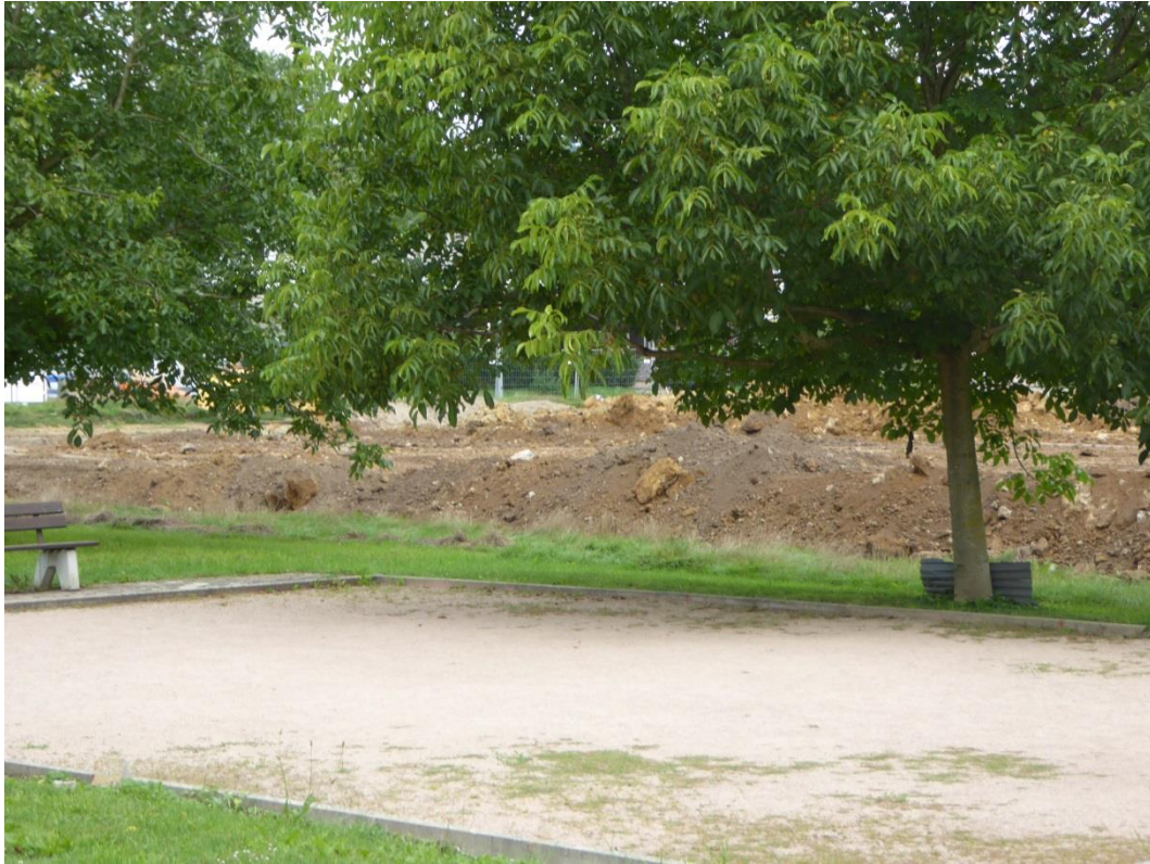
24. August 2019 Der Bouleplatz liegt bereits 1m tiefer
