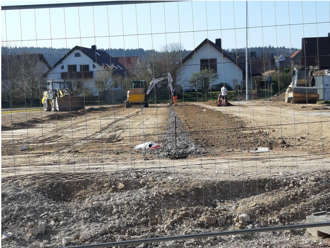
7. April 2020 Einbau der Drainage
