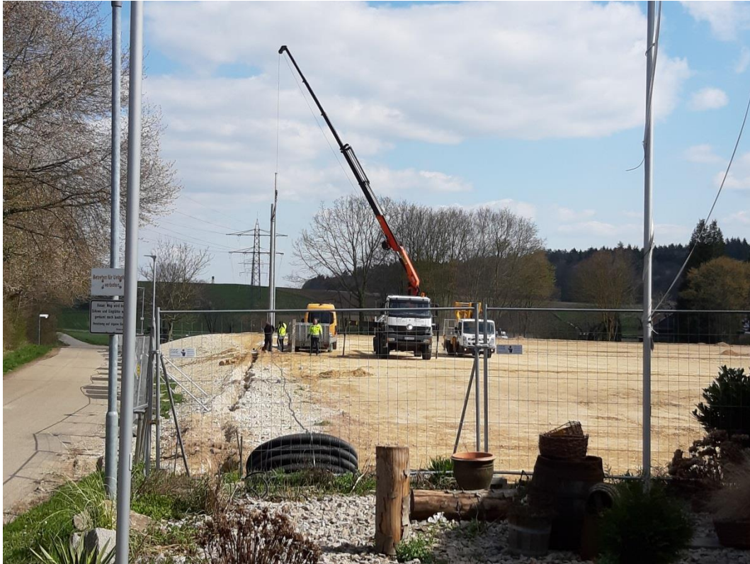
31. März 2020 Setzen der Flutlichtmasten
