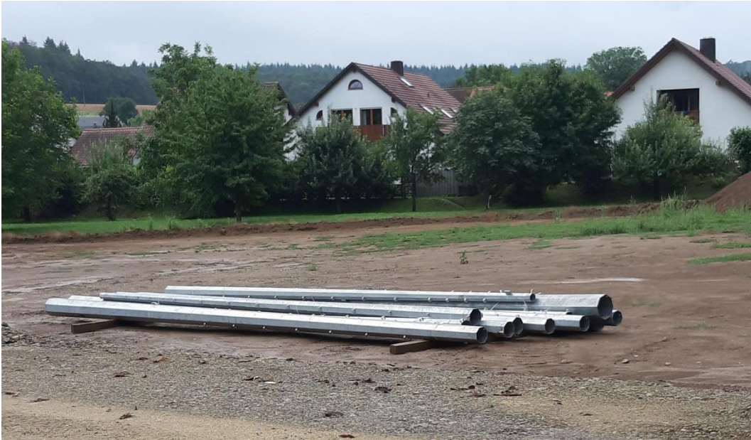
7. Juli Die neuen Flutlichtmasten werden geliefert
