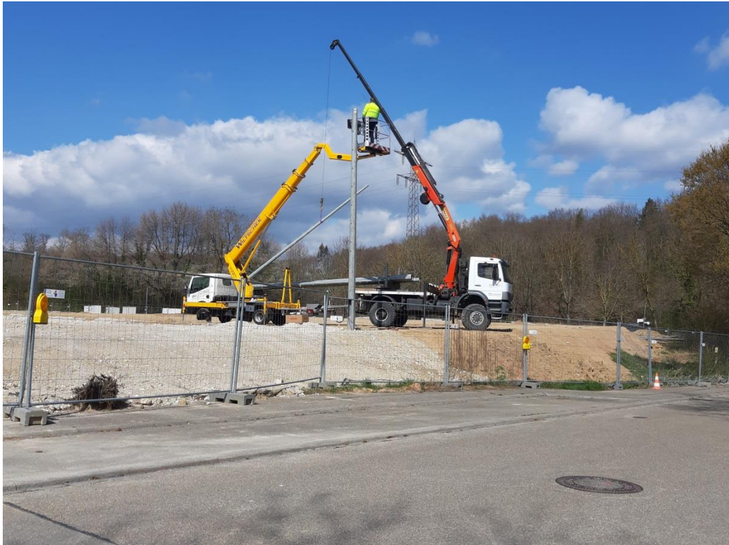
31. März 2019 Setzen der Flutlichtmasten
