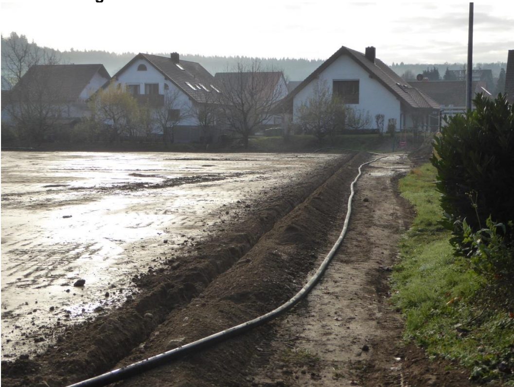
30. November 2019 Verlegung der Wasserleitungen
