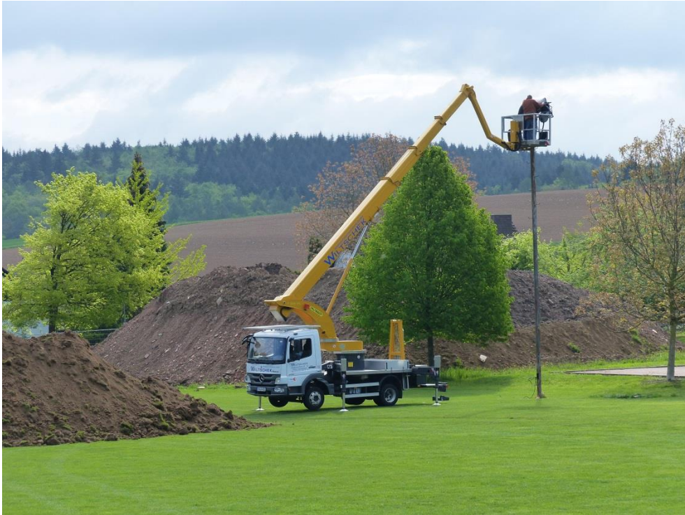
3. Mai 2019 Abbau der Flutlichtscheinwerfer
