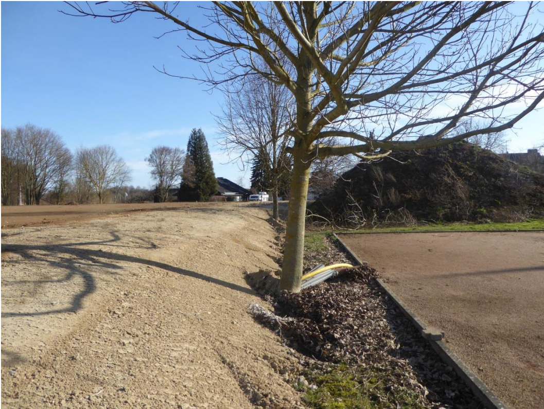
9. Februar 2020 Böschung an der Südseite
